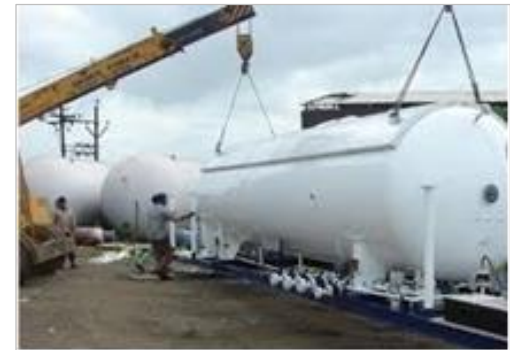
Cylindrical C-Type LNG Tanks
